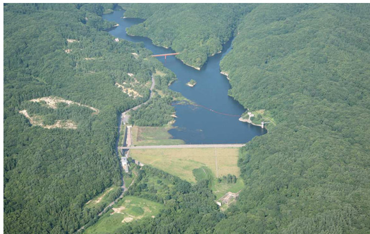
飯詰ダム（五所川原市）
