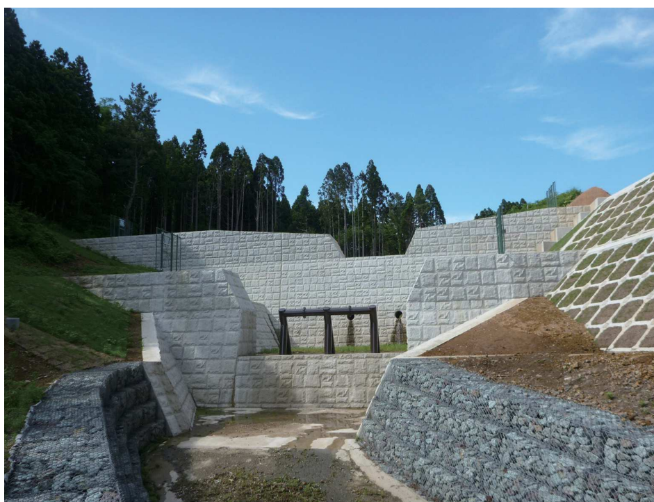
平成25年完成 吉花沢2号堰堤(深浦町)
