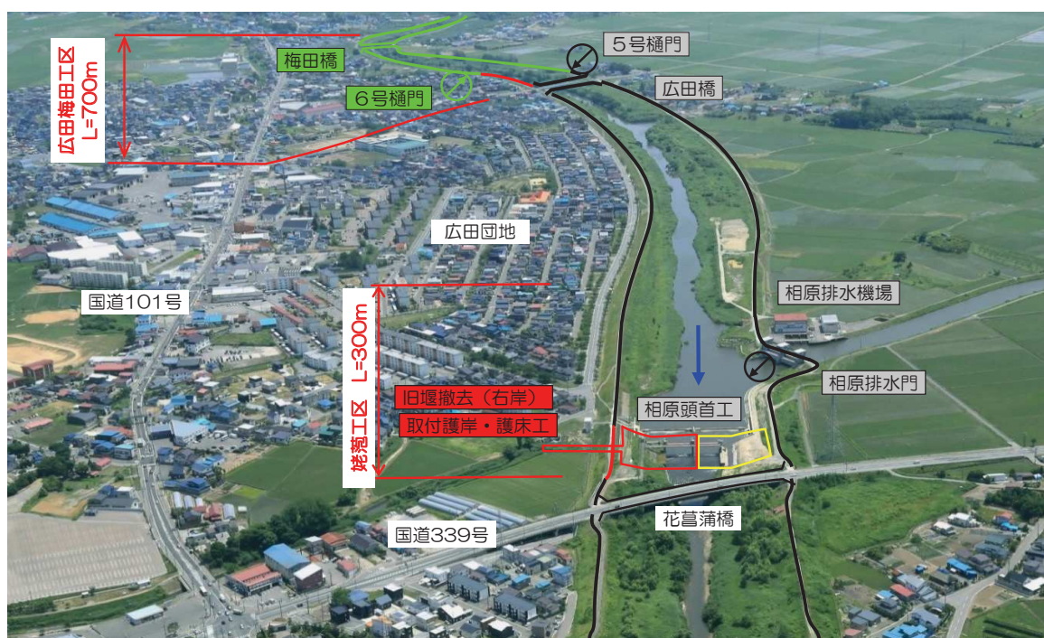
十川広域河川改修事業（五所川原市）
