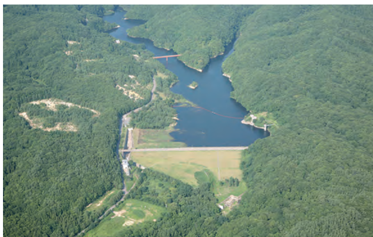
飯詰ダム（五所川原市）
