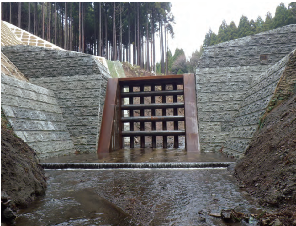
平成26年完成 玉坂2号堰堤(深浦町)
