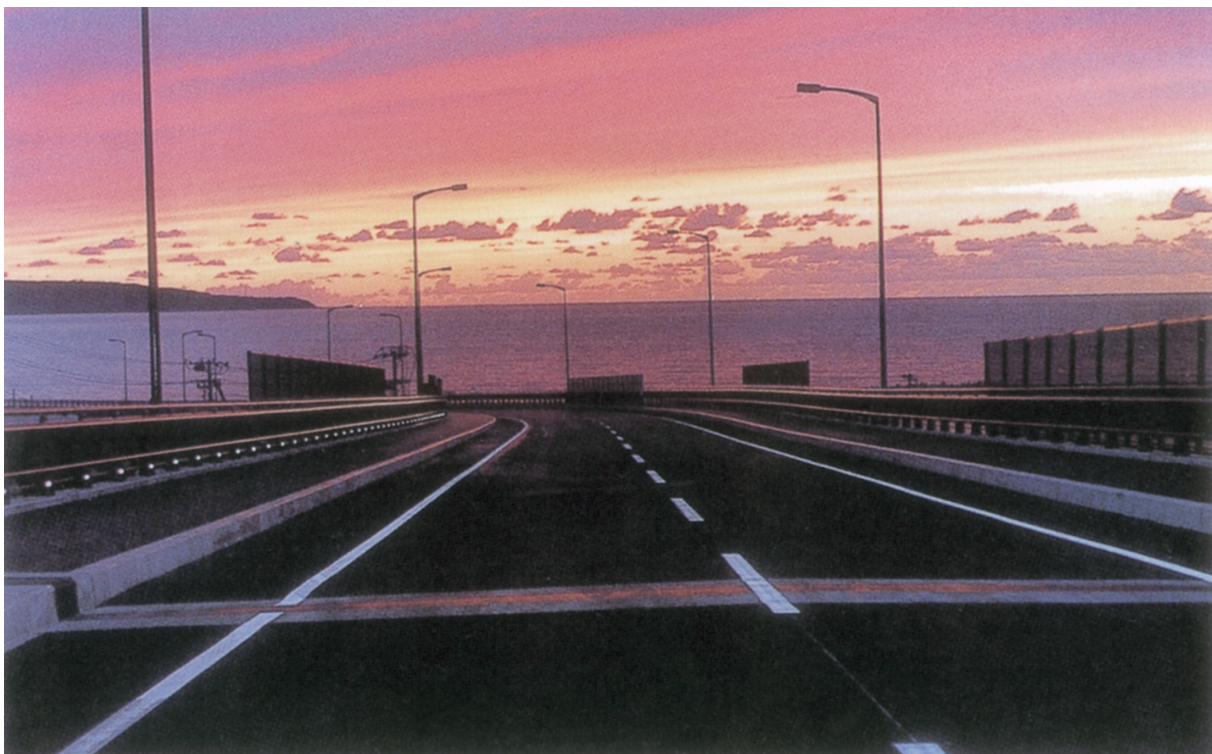
国道 101 号国道改築事業（鱒ヶ沢バイパス：鱒ヶ沢町）
