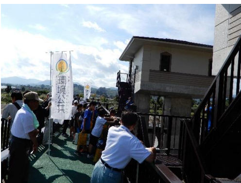
〈岩木川統合頭首工〉
