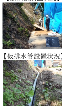
【敷鉄板設置状況】
