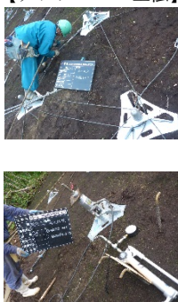
【ノンフレーム工法】
