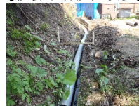
【仮排水管設置状況】
