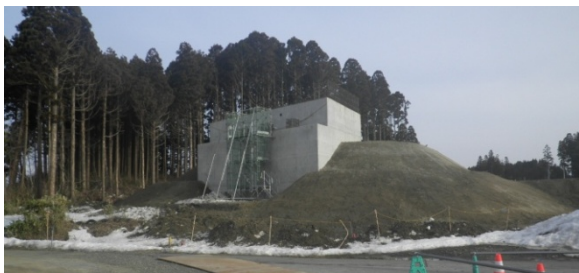
完成写真 (A1 橋台及び路体盛土)
