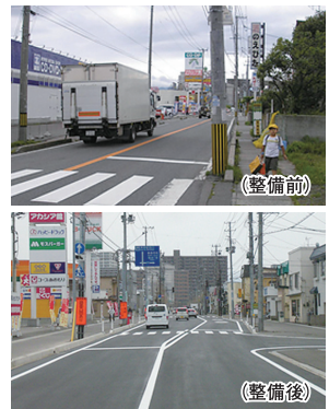
国道280号交通安全事業(青森市柳川工区)
