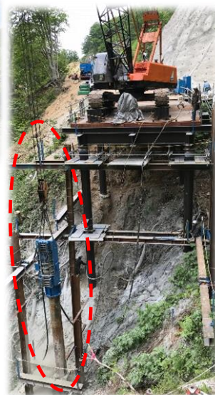
杭打ち機による施工状況 (写真：H30.6.8撮影)
