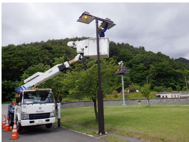
浅虫ダム（照明灯ランプ交換：平成30年6月）
