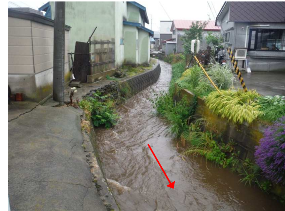
浸水被害状況(油川地区(下流部)、H2.9.19~20)
