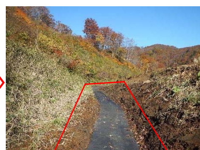
【完成】 吸出防止材を巻いて完成
