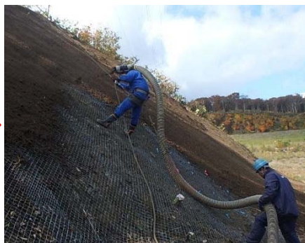
【施工中】 チップ材の吹付状況
