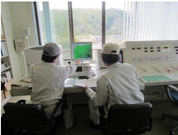
警報局の警報起動・動作確認
