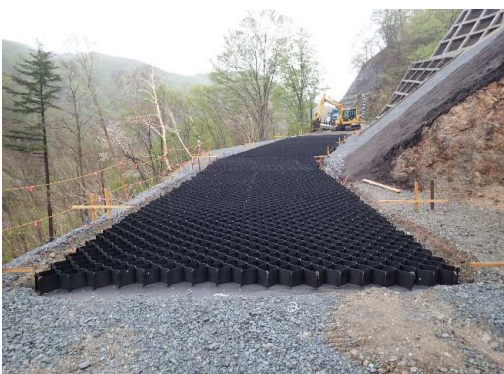
写真② ジオセル路盤工（ジオセル：高密度ホリリソで出来たに加状の軽量型枠）
