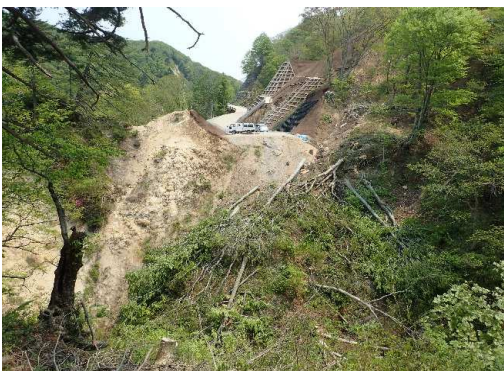
写真① 伐木が終了した3号橋梁区間
