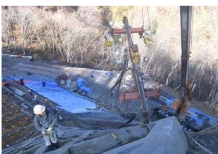
写真-5 鉄筋挿入状況
