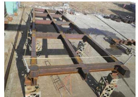
橋梁製作工場での仮組状況
