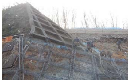
写真-4 法枠モルタル吹付状況
