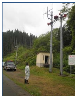
サイレン・回転灯・スピーカの起動を確認するOさん
