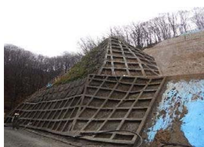
写真-6 法枠完成状況
