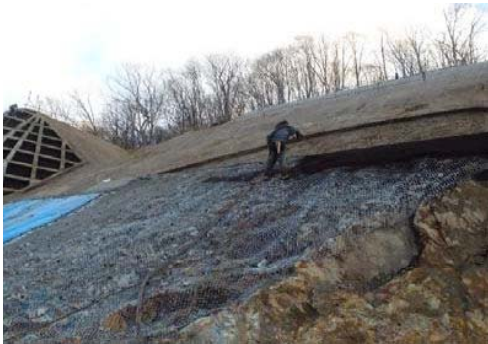
写真-1 植生基材吹付状況
