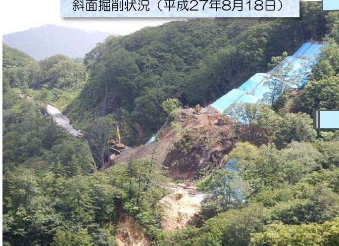
斜面掘削状況（平成27年8月18日）
