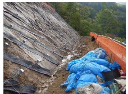
写真-4 湧水部処理状況
