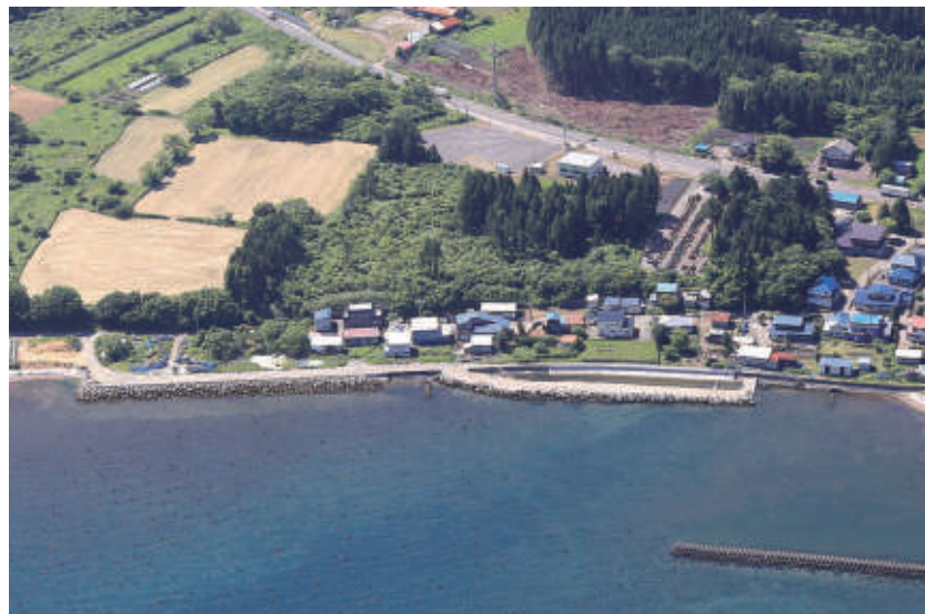
□広海岸 海岸堤防老朽化対策緊急事業
