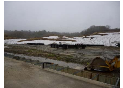
4月27日 工事材料搬入
