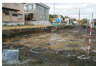
深層混合処理完成
