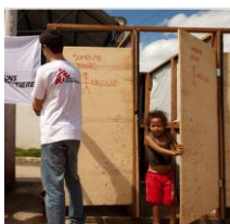
トイレの設置
