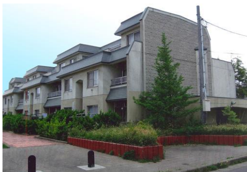
県営住宅の緑化(五所川原市)
