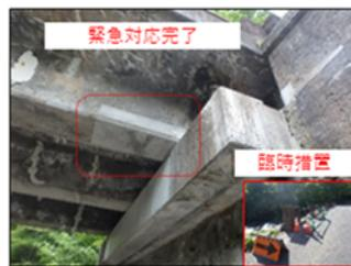
主桁下面の断面修復(通天橋)
