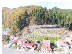
ドローン上空撮影
