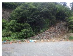
モノレール架設完了
