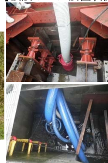
【仮設ポンプ設置状況】
