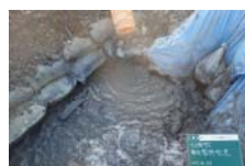
硫化水素ガス噴出状況
