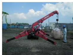
カニクレーン試験施工
