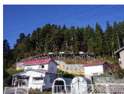
作業足場組立完了
