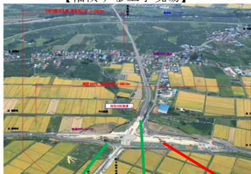
【輻輳する工事現場】
