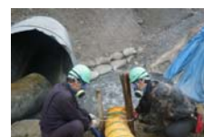
防毒マスクを着用し施工
