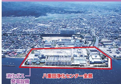
八重田浄化センター全景
