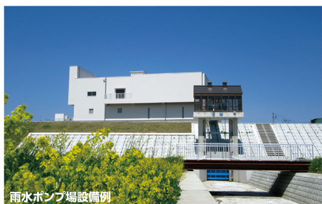
八戸市 尻内雨水ポンプ場
