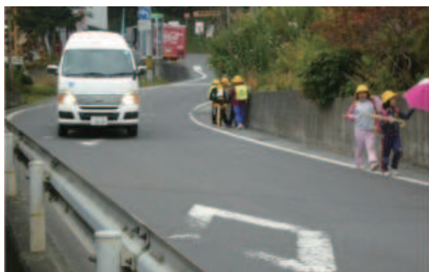
歩道の未整備区間 (国道454号 新郷村)
