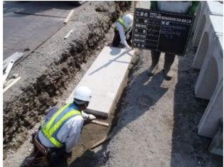
プレキャスト基礎版を利用した排水構造物基礎工
