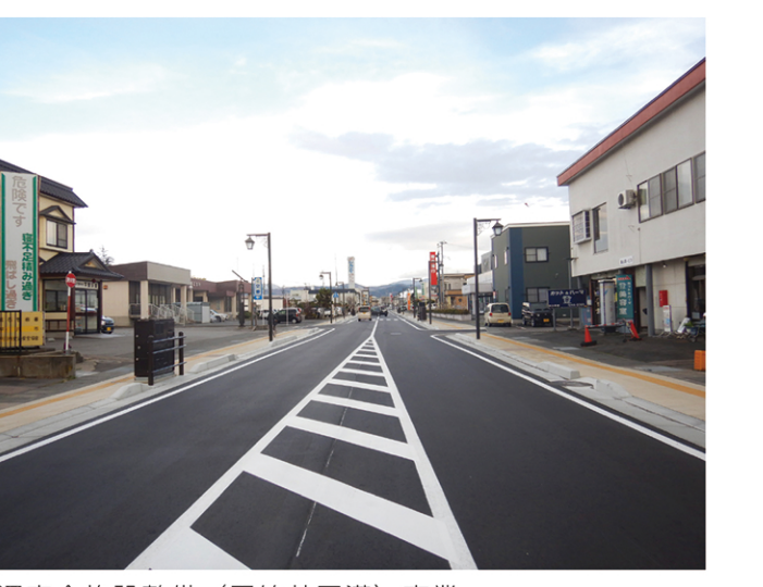
交通安全施設整備(電線共同溝)事業(町志平町停車場線・松木町工区：令和3年12月完成)
