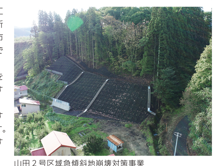
山田2号区域急傾斜地崩壊対策事業
