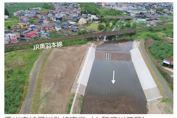
平川広域河川改修事業(大沢川工区)
