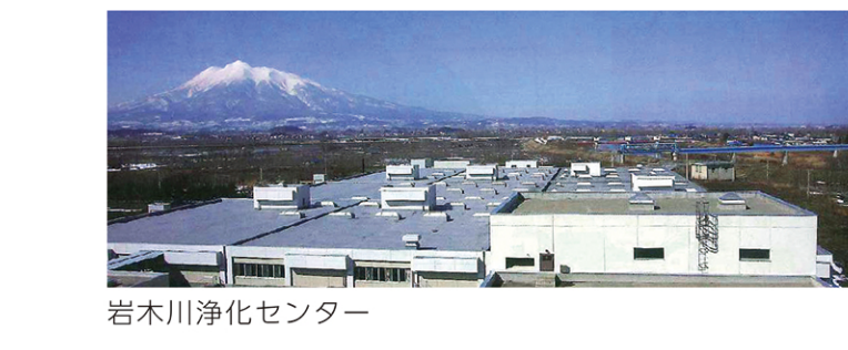
岩木川浄化センター
