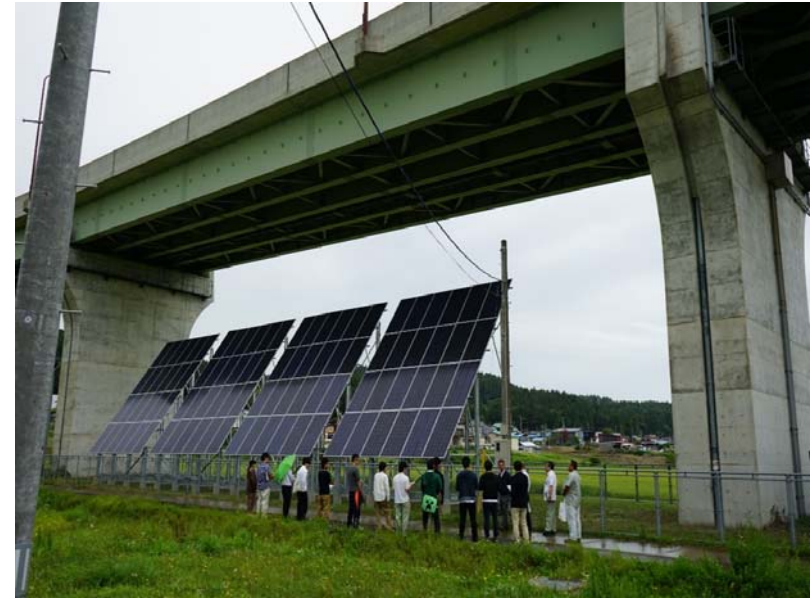
－現場見学（桁下空間を活用した太陽光発電施設）－
