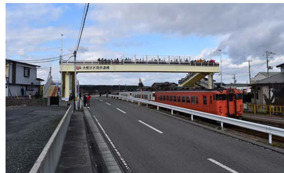
避難時間短縮のために設置した歩道橋 (階上町)
