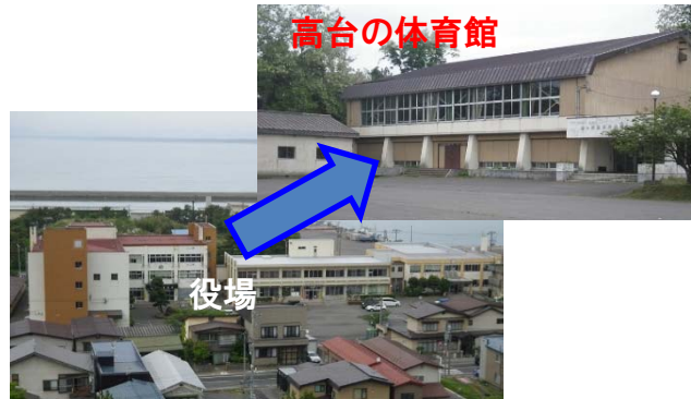
浸水区域にある役場の機能を高台へ移転 (鯉ヶ沢町)
