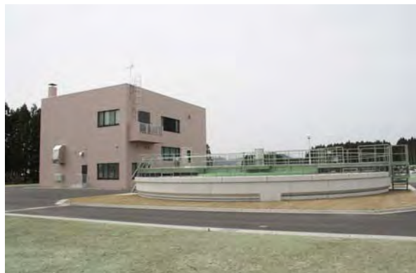
●蟹田浄化センター（外ヶ浜町：平成24年度供用開始）
