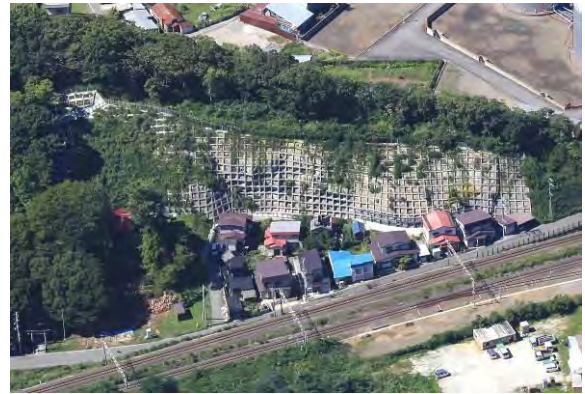
●浦島区域急傾斜地崩壊対策事業（青森市）令和2年度
