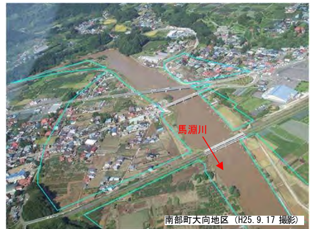
● 馬淵川広域河川改修事業 (南部町・三戸町)
