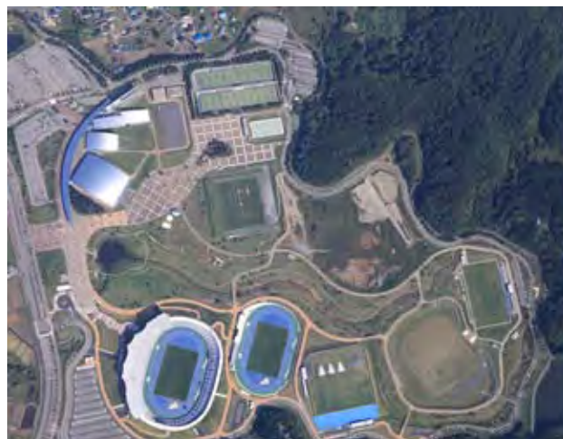
●新青森県総合運動公園（全景：青森市）
