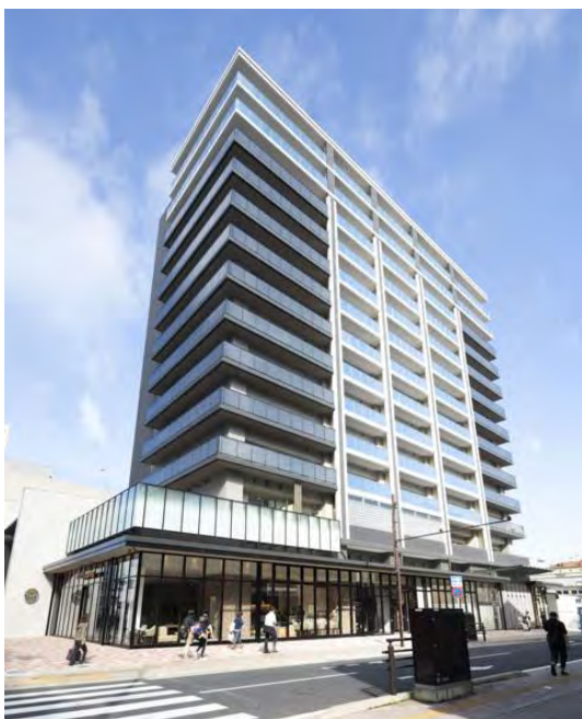
優良建築物等整備事業（八戸市 八日町地区）
