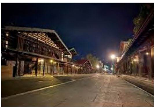
街なみ環境整備事業（黒石市 中町周辺地区道路美装化）
