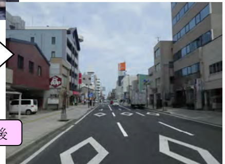
▼電線共同溝の実施例 国道 340 号[八戸市廿三日町]
