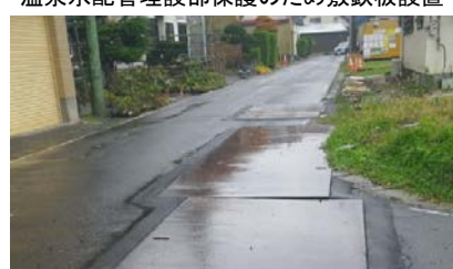
温泉水配管埋設部保護のため敷鉄板設置
