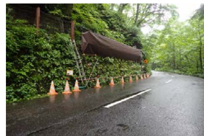
茶系シートによる養生(仮設足場)
