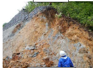
法面崩壊状況
