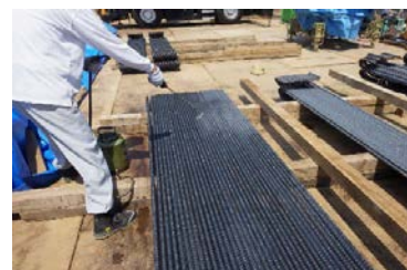
鉄筋の防錆処理
