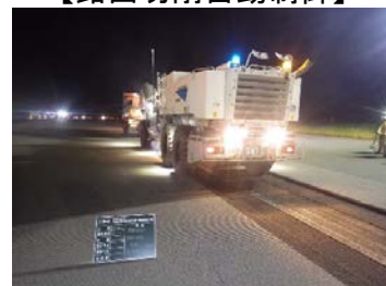
【安全対策施工機械照明】
