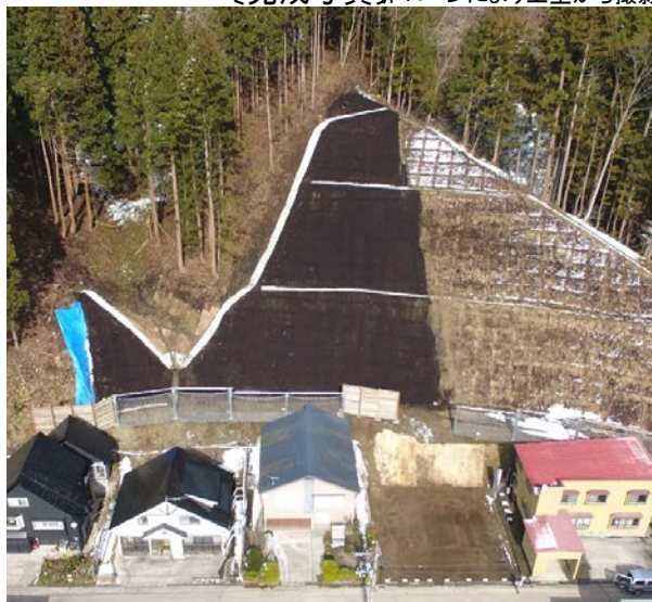
[完成写真]ドローンにより上空から撮影) セーフティクライマー工法作業状況
