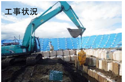
大型土のうと矢板による養生 (湧水対策・床掘法面の安定化)
