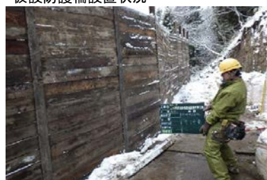
温泉水配管埋設部保護のため敷鉄板設置
