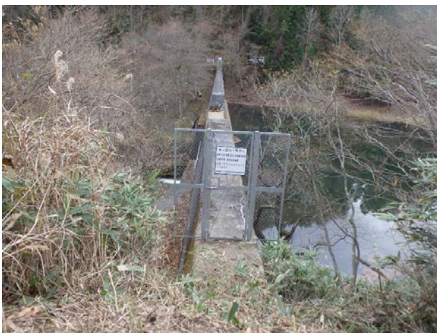
○測量位置(市の渡川砂防ダム)
