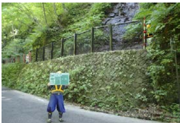
完成(国道102号:落石防護柵)
