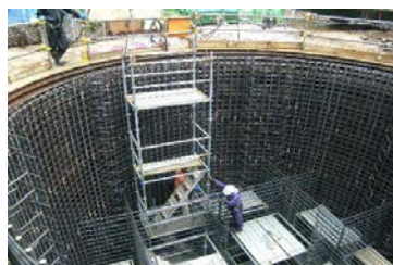
大口径深礎工
