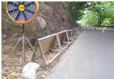
木製バリケードの設置
