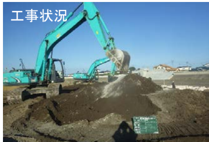
改良機設置箇所の安定処理 (軟弱地盤対策・地盤改良の品質確保)
