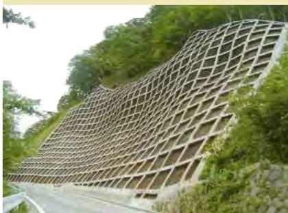
現場吹付法枠＋緑化
