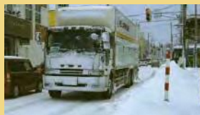
路肩堆雪による幅員狭小状況
