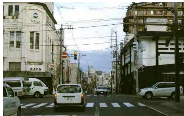
電線類の錯綜（主要地方道弘前岳鯨ヶ沢線 弘前市）
