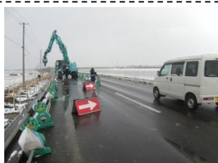
小旋回バックホウによるH鋼打ち込み
