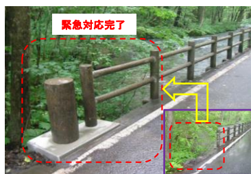
親柱・高欄脱落部の復旧(神明橋)
