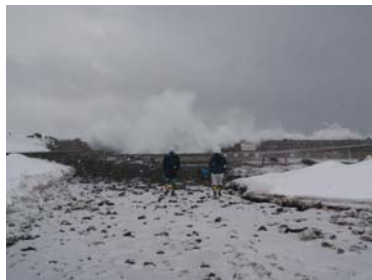
工事箇所越波状況
