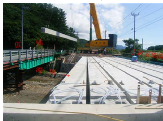
クレーン架設
