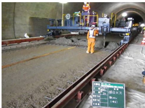
二車線同時施工状況（コンクリートスプレッダー運転）
