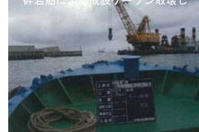
砕岩船による既設ケーソン取壊し
