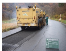
[切削機による舗装版撤去]
