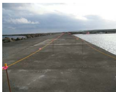
作業通路の明示
