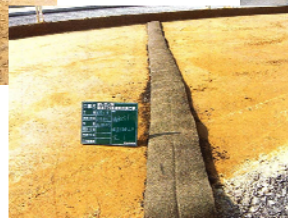
路床排水暗渠
