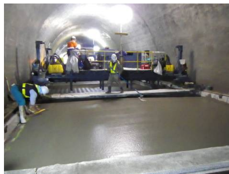
二車線同時施工状況（コンクリートスプレッダー運転）
