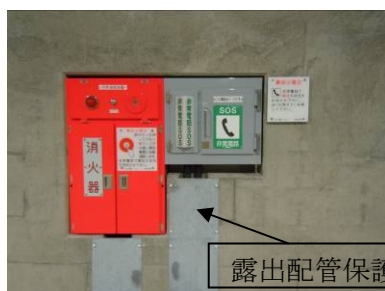
押釦通報装置と非常電話
