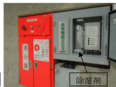
非常電話（除湿剤設置）
