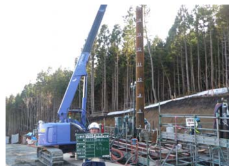
抑止杭施工状況
