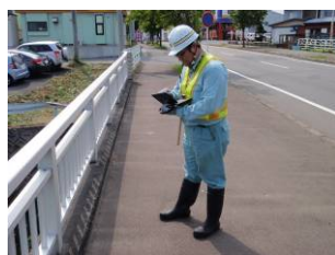
小型タブレットPCを利用した現地での点検結果入力
