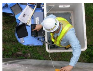
ひび割れ幅測定機による正確なひび割れ幅測定
