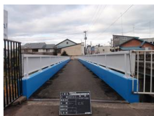
塗装工完成全景(七戸橋欄干歩道橋)
