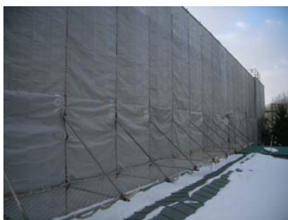
飛来落下の防止(朝顔の設置)
