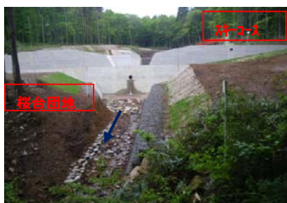
完成写真【下流側】
