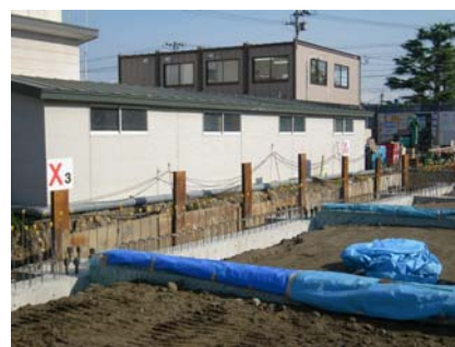
作業スペースの確保(簡易矢板杭設置)
