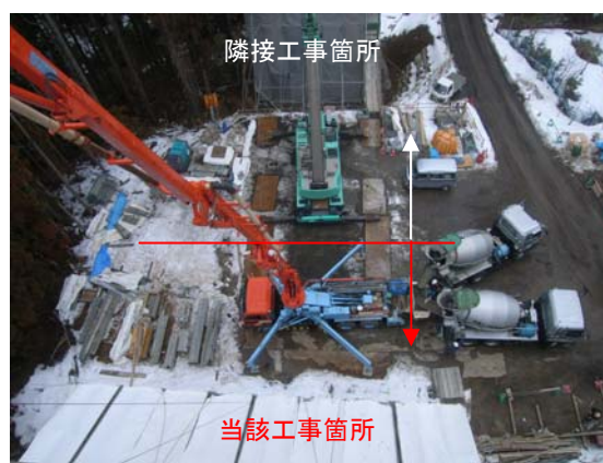
狭隘な施工ヤード
