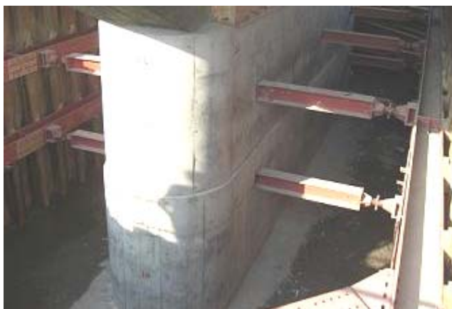
巻立てコンクリート完了(柱部)
