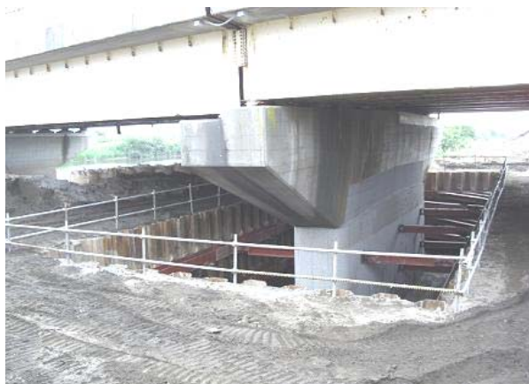
土留・仮締切完了(切梁受金具使用)
