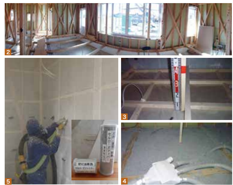
1 リビング吹抜 : 大きな吹き抜けで明るく開放的なリビング。南側には日光を取り込むFIX窓、東西には熱を取り込む室内窓を設置。 2 構造 : 柱と柱の間に斜めに入れる筋交いで、建物のゆがみを防ぎ、構造体の耐震性を高める。(パノラマ合成写真) 3 天井裏 : 断熱用セルローズファイバーを吹き込む前。 4 天井裏 : 30cm以上の厚みになるようしっかり吹き込む。こうすることで、外が暑くても寒くても、家の中は過ごしやすい快適な温度を実現。 5 断熱施工 : 付加断熱として、壁に通常105mm、外側45mmの合計150mmのセルローズファイバー断熱材を充填し、断熱性能を高める。
