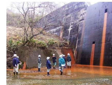
作業部会による現地調査
