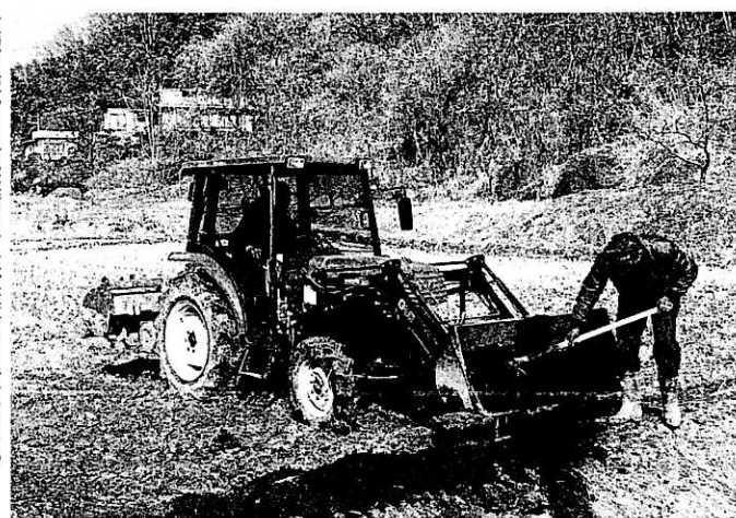
重機を使った土地整備も、建設業者なら慣れたもの
