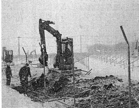
来年4月の発電事業開始に向け、工事が進められるメガソーラー建設現場=27日、三沢市三沢小山田
