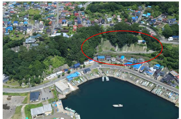
●万年坂区域急傾斜地崩壊対策事業(深浦町)事業中
