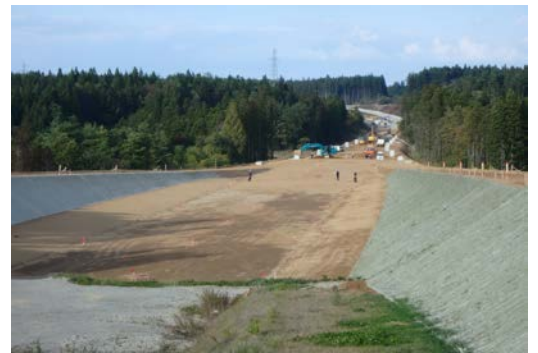
▲改良工事が進むむつ南バイパス
