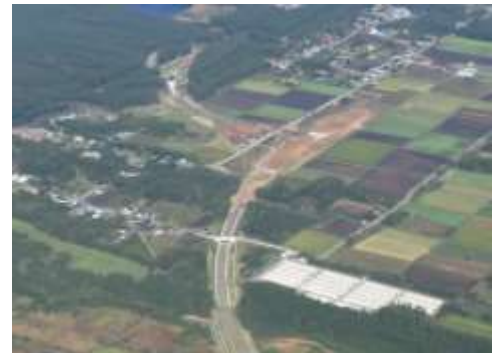
▲H29供用に向け工事が進む吹越バイパス
