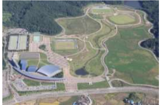
●新青森県総合運動公園 整備中(青森市)
