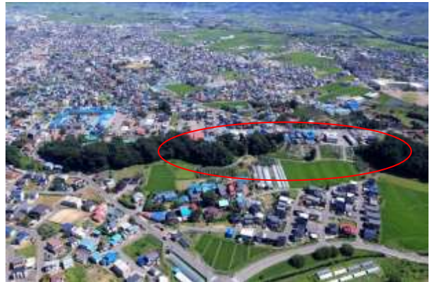
●長崎区域急傾斜地崩壊対策事業（黒石市）平成28年度概成
