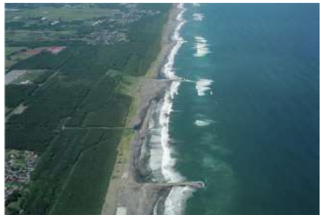
●三沢海岸の保全施設（ヘッドランド）
