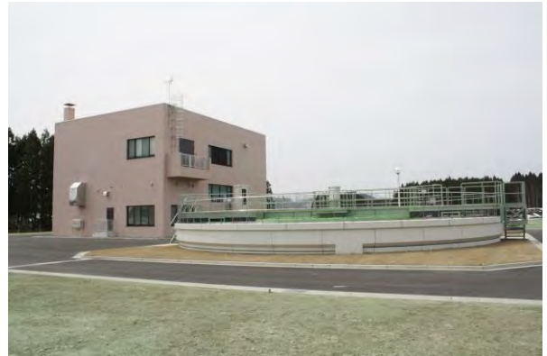
●蟹田浄化センター（外ヶ浜町：平成24年度供用開始）
