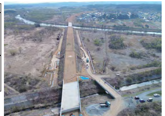
▲改良工事が進むむつ南バイパス
