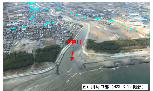
●五戸川地震・高潮対策事業（八戸市）
