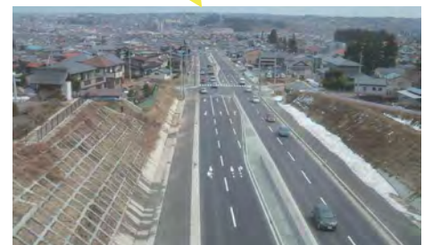
▲(主)八戸環状線糠塚工区開通状況 (平成26年3月20日開通)
