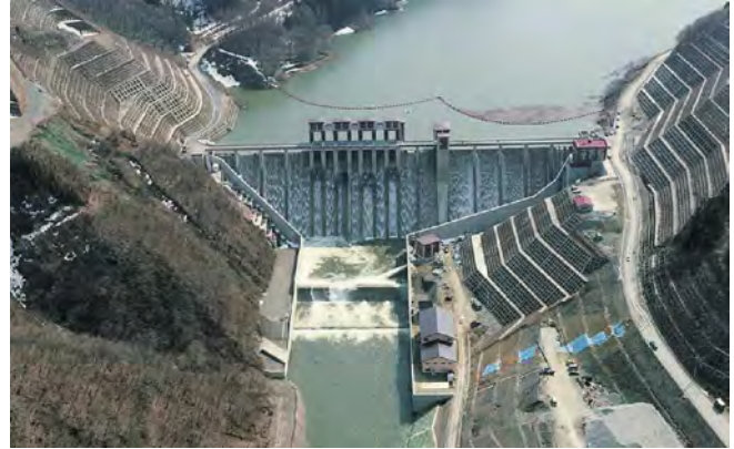
●世増ダム（平成15年度完成）
