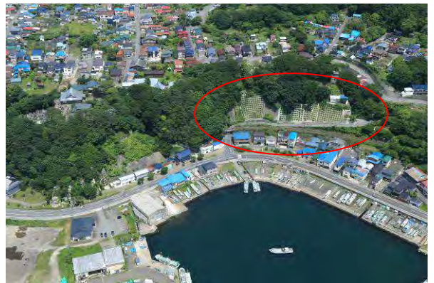
●万年坂区域急傾斜地崩壊対策事業（深浦町）事業中
