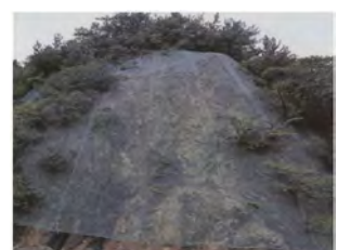
▼落石防護ネット
