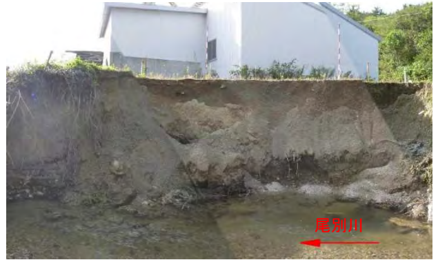
●H30 災 尾別川 右岸欠壊状況(中泊町)
