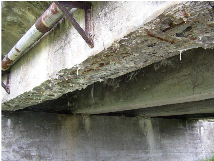
図 3-7 太平洋側の凍害を受けた橋梁
