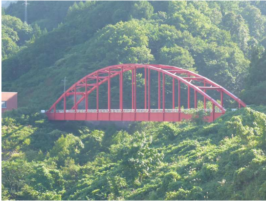
(一般) 酸ヶ湯高田線 松沢橋
