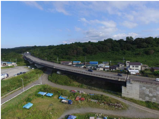
国道101号 蒼海大橋
