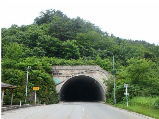
鱒ヶ沢蟹田線 やまなみトンネル
