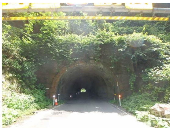
浅水南部線 手倉橋隧道
