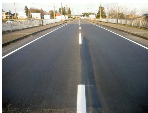
国道338号 大浦川橋【補修後】
