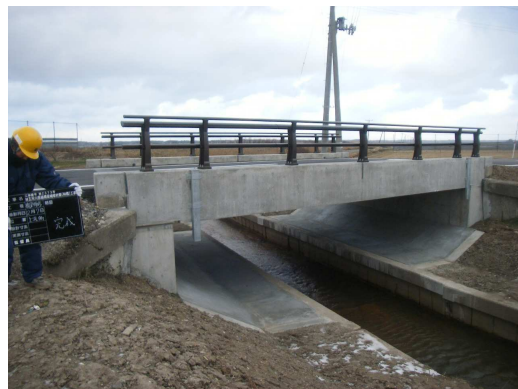
林五所川原線 林橋【補修後】
