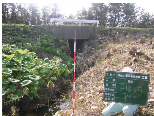
国道279号 第3雲雀平橋【更新前】
