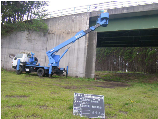
（アルカリ骨材反応の追跡調査・春）
