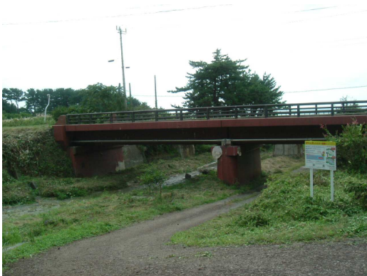
国道101号 濁川橋【更新前】
