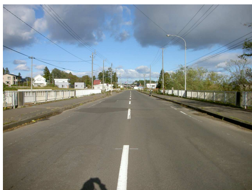
国道338号 大荒川橋【補修前】
