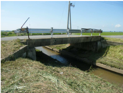
林五所川原線 林橋【補修前】
