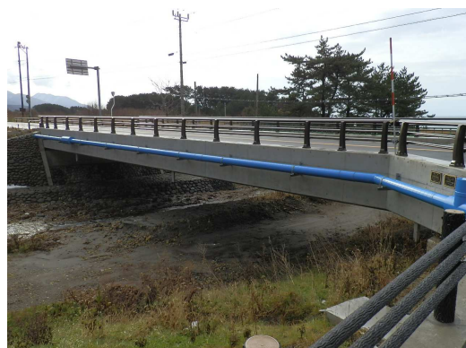
国道101号 濁川橋【更新後】
