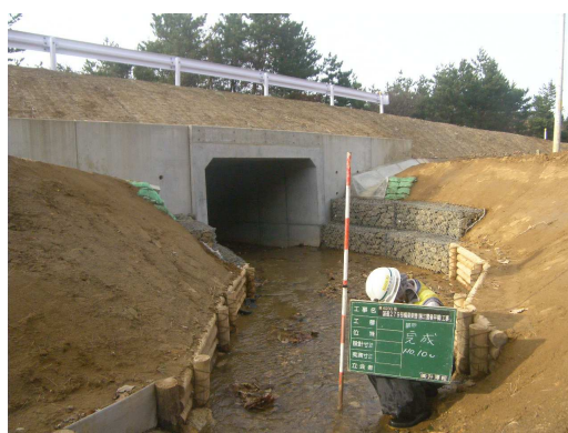
国道279号 第3雲雀平橋【更新後】
