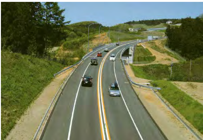
下北半島縦貫道路 野辺地バイパス
