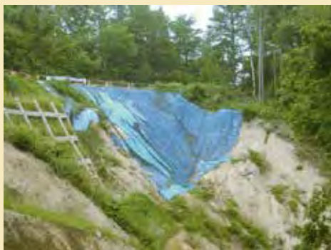
施工前(要対策)
