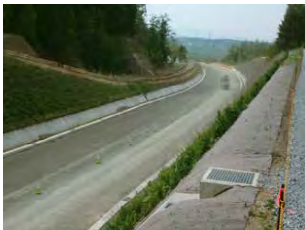
一般国道279号下北半島縦貫道路 むつ南バイパス 施工状況
