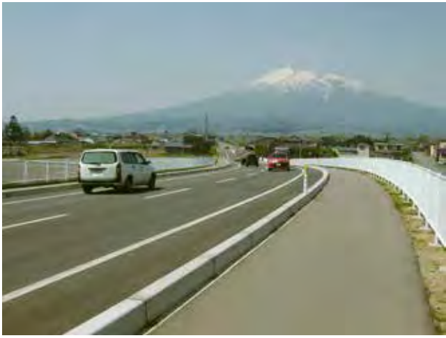
主要地方道 五所川原岩木線 掛落林工区 (平成27年12月11日開通)
