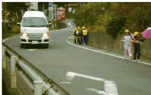
歩道の未整備区間 (国道454号 新郷村)
