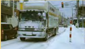
路肩堆雪による幅員狭小状況
