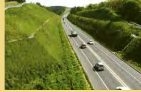
開通により安定走行が可能
