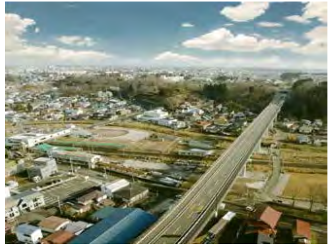
三沢都市計画道路 3・4・3号中央町金矢線 (平成29年3月30日開通)
