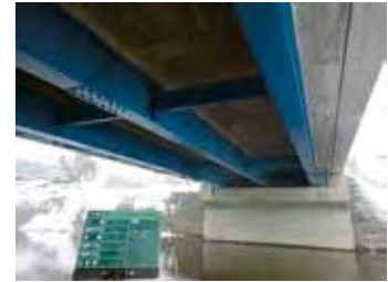
▲老朽橋の補修・耐震対策 国道338号 男川橋
