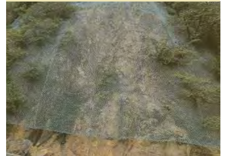
(主) 岩崎西目屋弘前線鱒ヶ沢町
