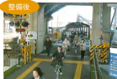
八甲田大橋の下に新設した踏切
