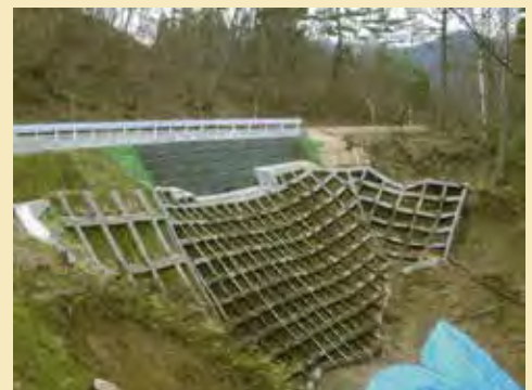
施工後(対策完了)
