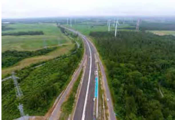
一般国道279号下北半島縦貫道路 吹越バイパス 完成間近
