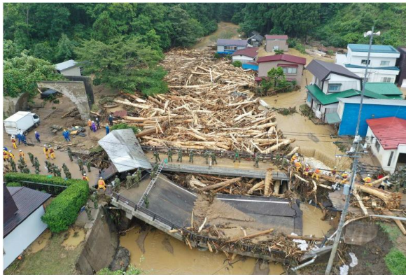
図10 令和3年8月9日からの大雨による 国道279号(むつ市)被災状況
