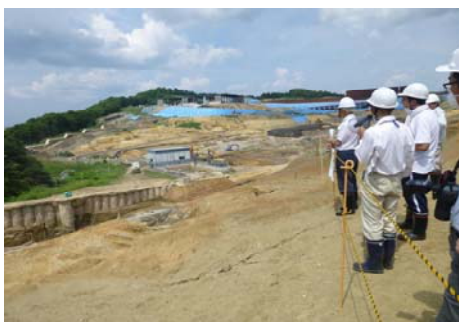
地山確認の状況（西側）
