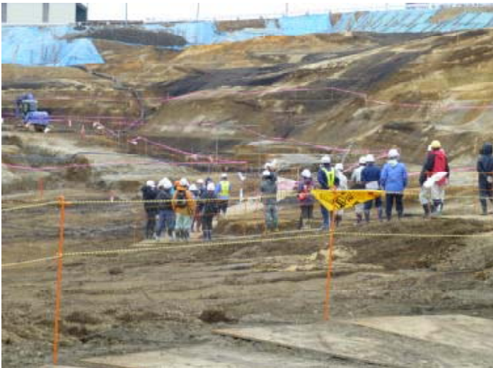
地山確認の状況
