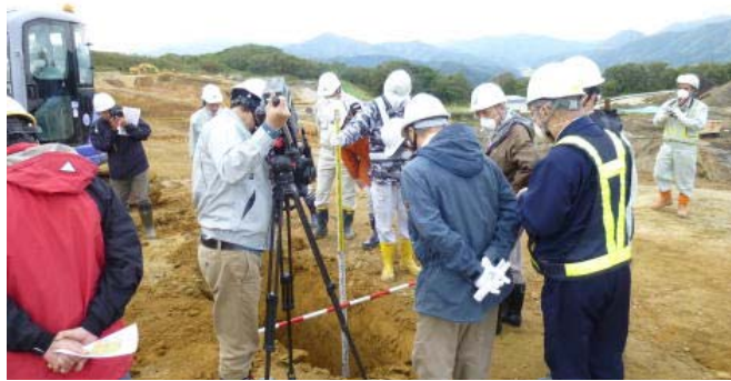
試掘箇所確認状況
