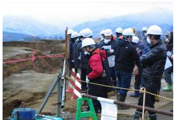
地山確認の様子
